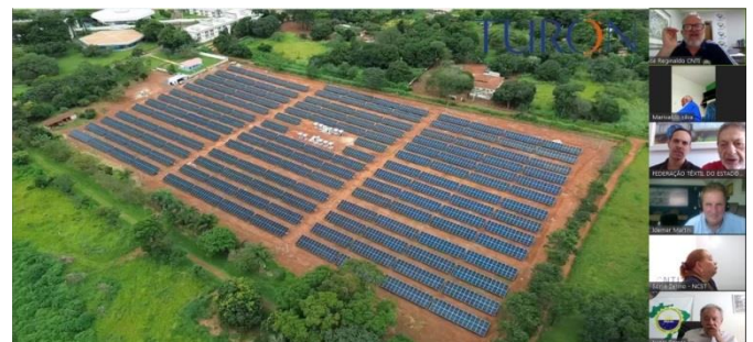
Vista Aérea Usina de Energia Fotovoltaica
